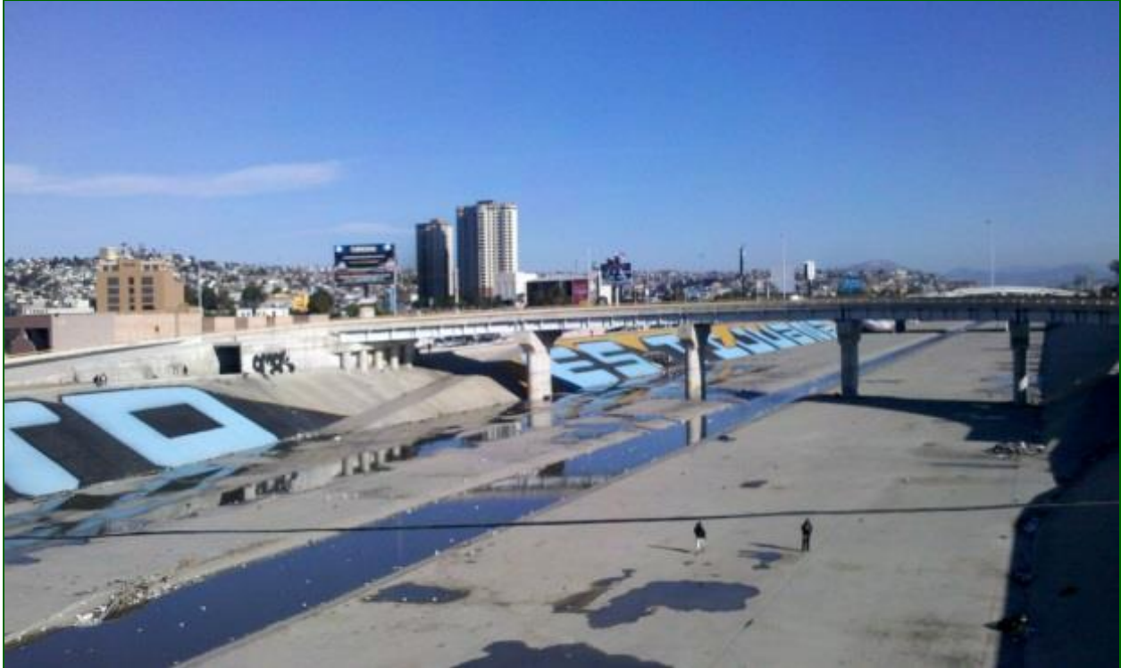
Figura 19. Aspecto de la Canalización del Río Tijuana “el canal”
