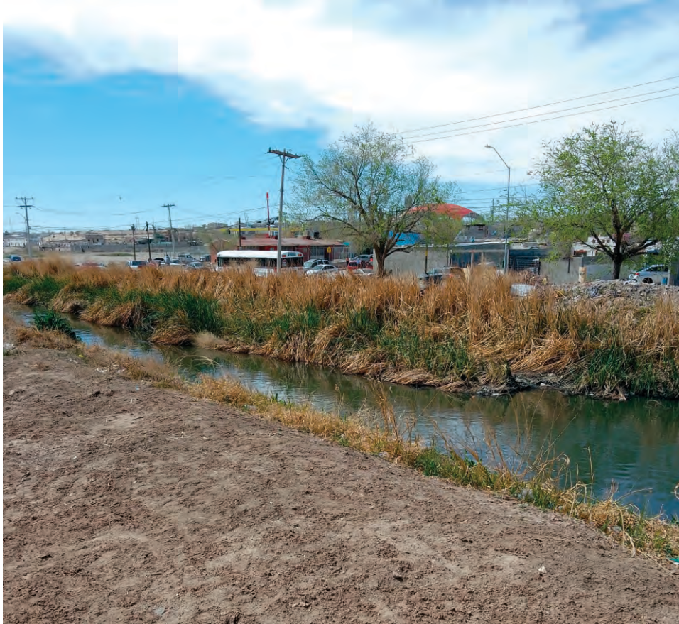
Imagen 3. Canal de aguas negras
